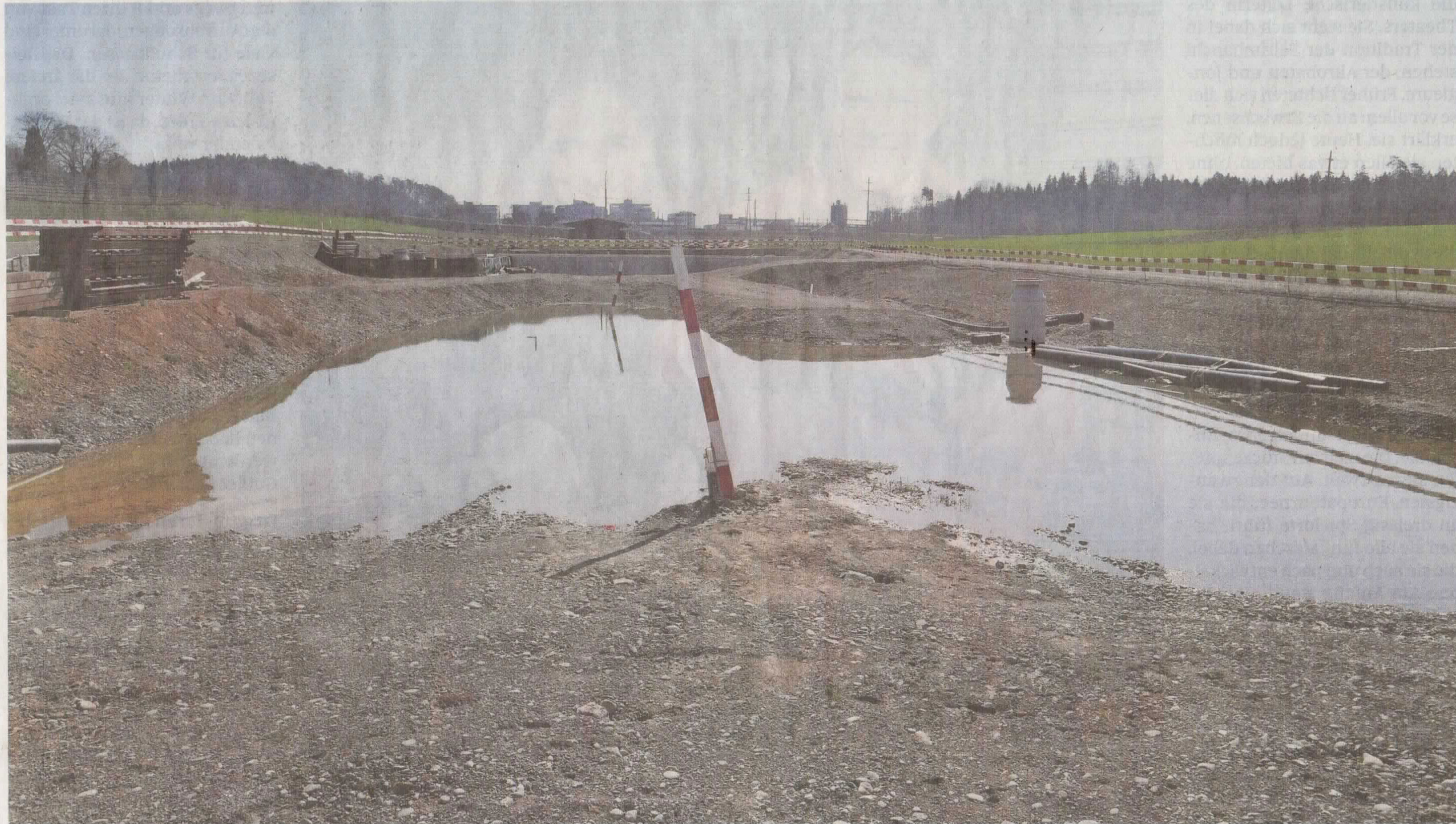
Ein Tümpel auf der Baustelle der neuen Versickerungsanlage im Gebiet Schoren hat einen Baustopp bewirkt. Experten hatten in dieser Tiefe kein Wasser erwartet. Foto: Madeleine Schoder
